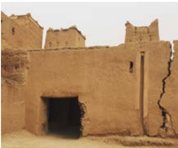
Restauración de la puerta fortificada del ksar Ait Aisset au Brahim.
