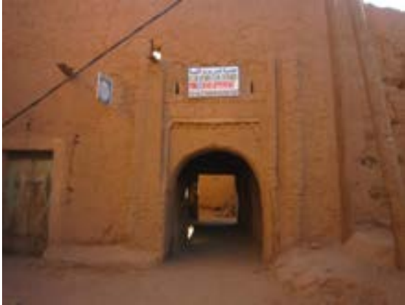
Restauración de la puerta fortificada del ksar Bounou.
